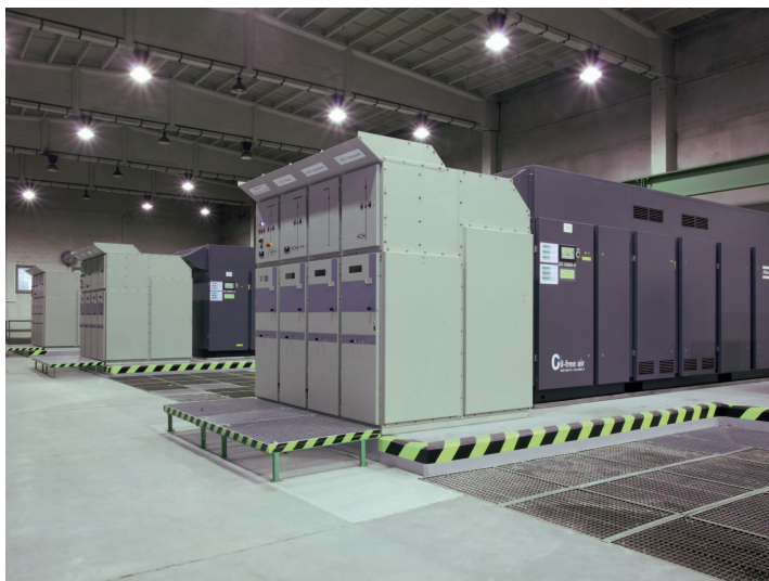
Druckluftanlage für Stahlindustrie, Eisenhüttenstadt
